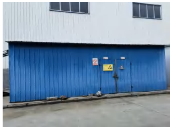
一般固废暂存间和危废暂存间
