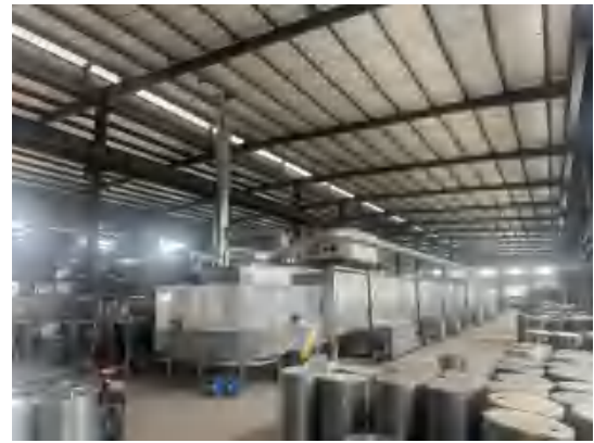
本项目清洗线
