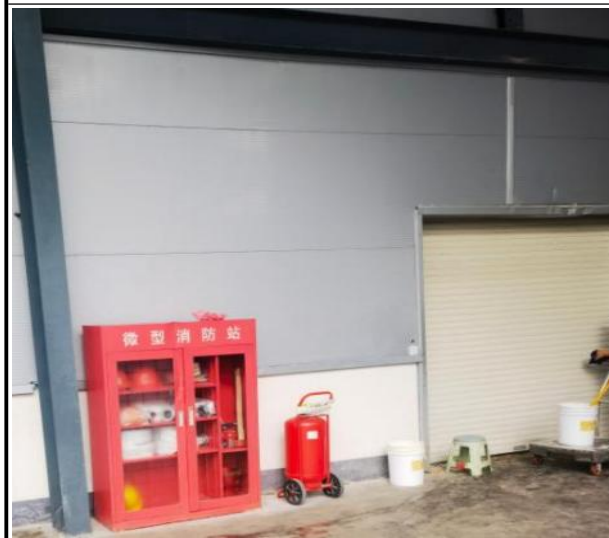
一般固废暂存间
