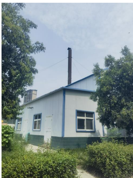
锅炉废气排放口
