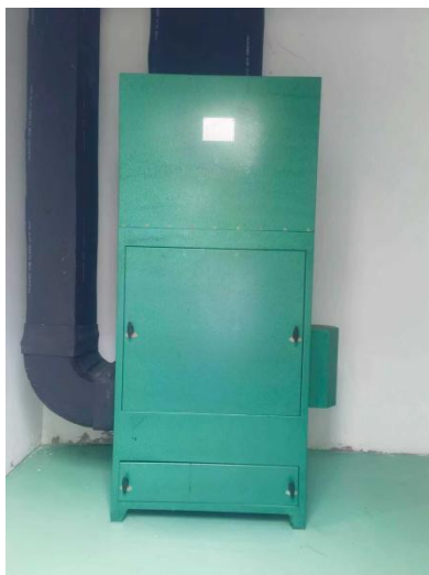
粉碎间、干燥制粒间和总混间袋式除尘器
