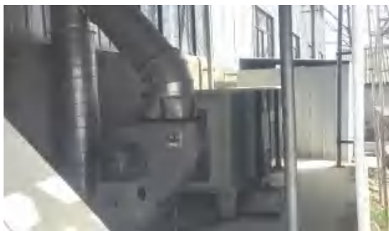
固化/燃烧废气治理设施
