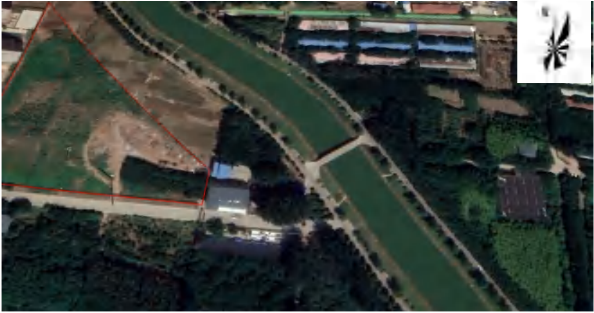
地块东侧（河流及一栋建筑）
