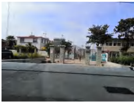
地块南侧黄庄变电站
