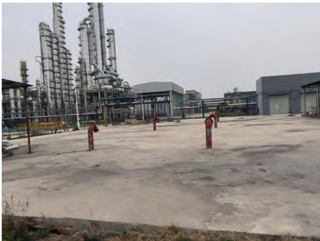
项目事故水池
