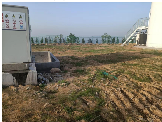
部分风电机组基座植被恢复 2
