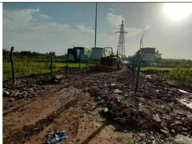
开关站植被恢复进展道路平整
