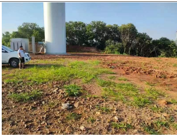
部分风电机组基座植被恢复 1
