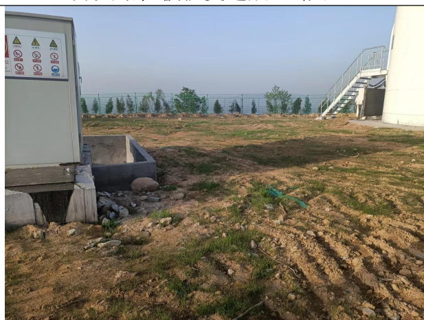
部分风电机组基座植被恢复 2
