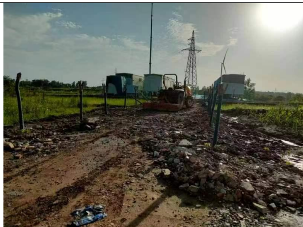
开关站植被恢复进展道路平整
