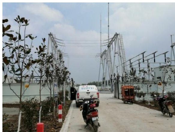
升压站进站道路现状
