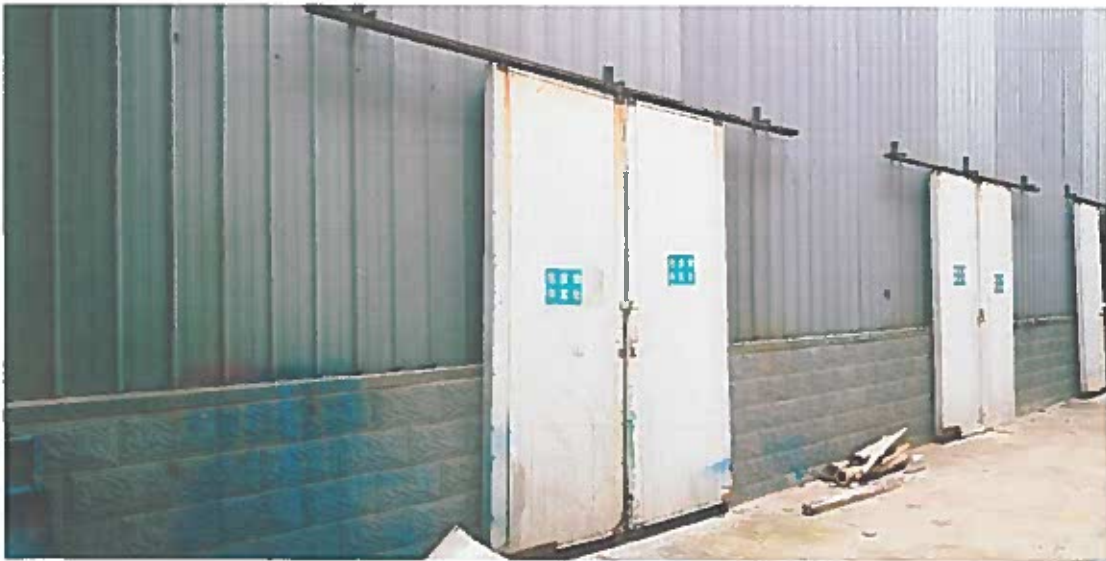
项目设置的固废暂存间及危废暂存间
